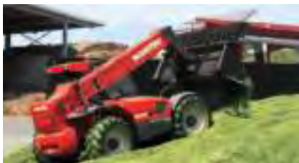
MLT 845 : réalisation de silo
