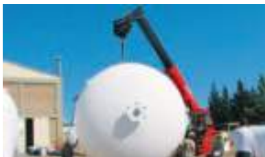
MHT 10120 : déchargement de réservoir sur une base
