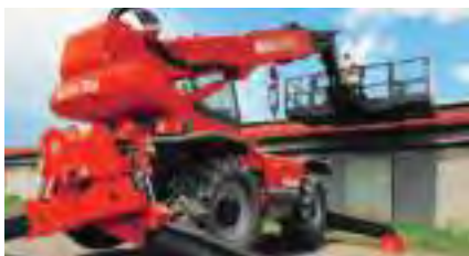
MRT 2150 avec nacelle : opération de désamiantage
